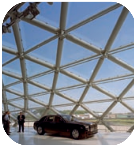
Im Cockpit befindet sich der ca. 5.000 m 2 große Showroom des Autohauses Hessing.
